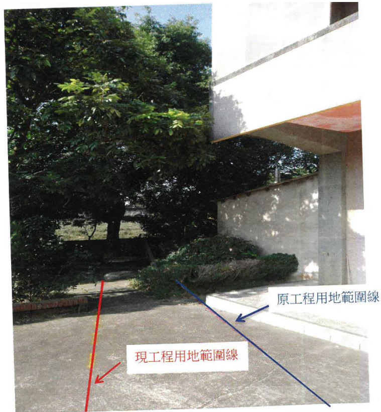
1212 地號土地現況
