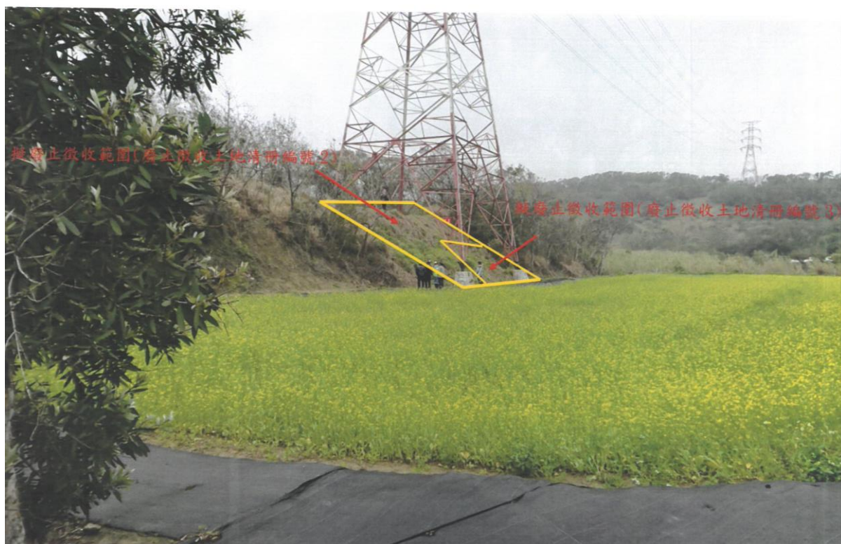
通霄~苗栗一進一出白沙 161kV 線 #3 鐵塔用地 (廢止徵收土地清冊編號 2、3)
